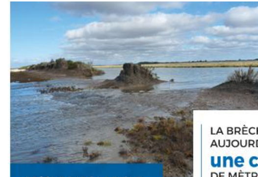
BRECHE DANS LA DIGUE DE PREMIER RANG
