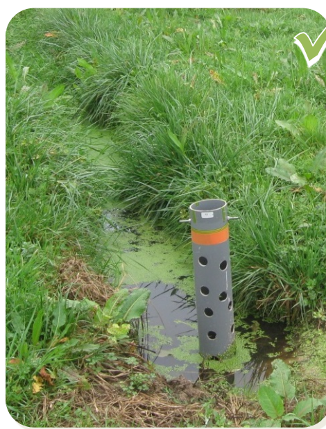
Plot perforé amovible permettant d'ajuster niveau et débit (réalisation PHYTOREM)
