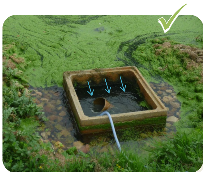
Plot perforé permettant de retenir les lentilles, surverse possible si niveau d'eau supérieur
