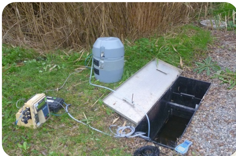
Canal de mesure en sortie de ZRV
