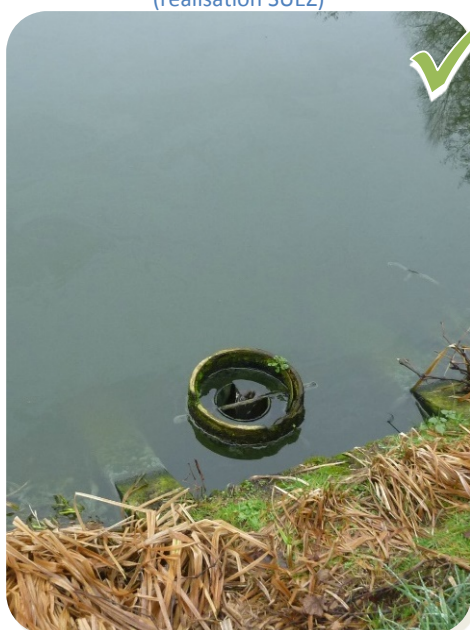
Déversoir à cloison siphonide
