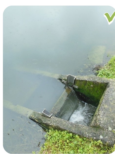
Surverse à hauteur réglable et amovible (planches dans un rail - inspirée du « moine »)
