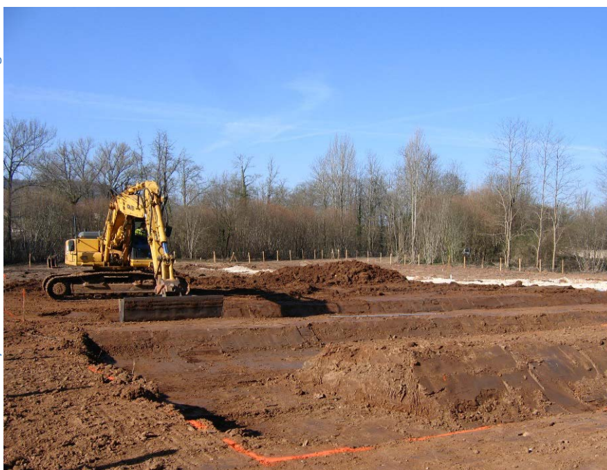
Les coûts de travaux concernent essentiellement le terrassement.
